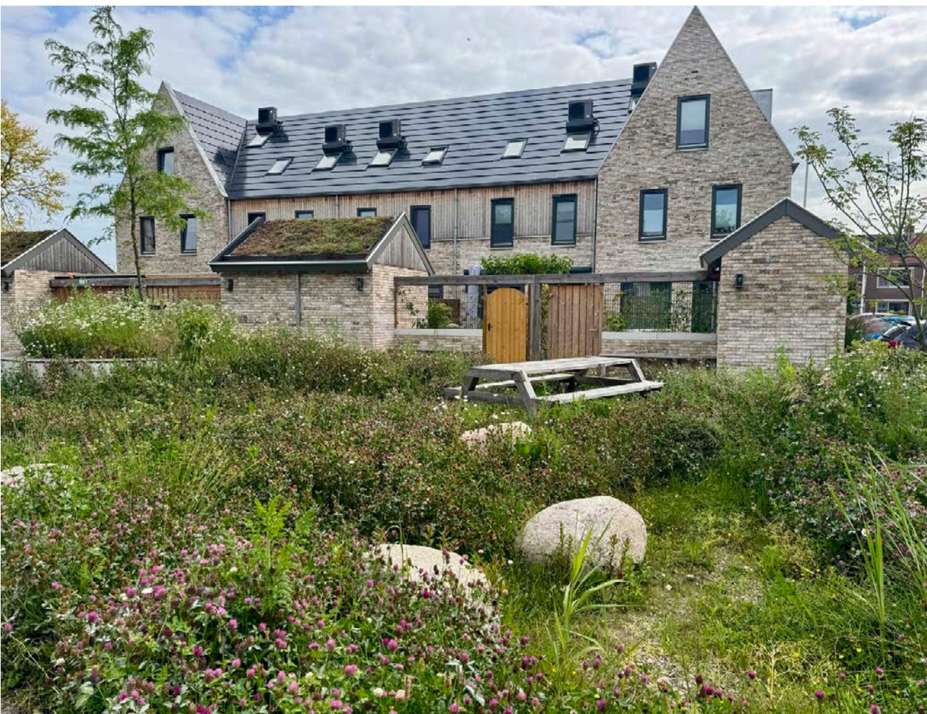
Overgang met hekwerk en bergingen van privé naar openbaar
